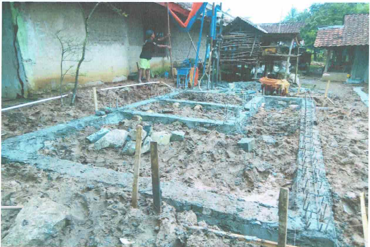
FOTO-FOTO KEGIATAN BANTUAN PEMBANGUNAN DAN RENOVASI SARANA PRASARANA IBADAH DAN PRASARANA AIR BERSIH DAN MCK, BOGOR 25 APRIL 2019
