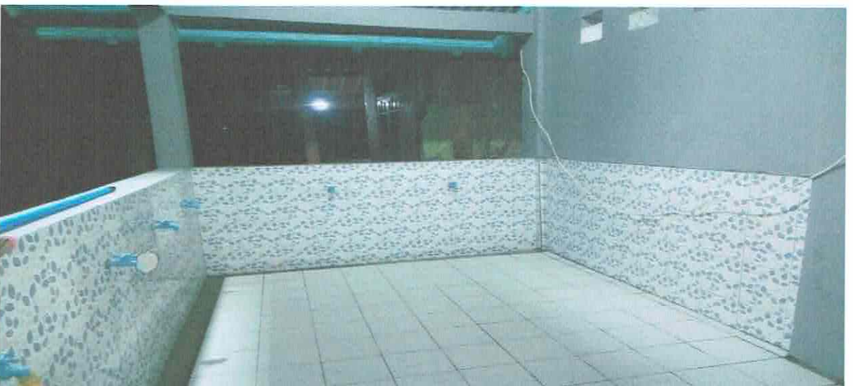
FOTO-FOTO KEGIATAN BANTUAN PEMBANGUNAN DAN RENOVASI SARANA PRASARANA IBADAH DAN PRASARANA AIR BERSIH DAN MCK, BOGOR 25 APRIL 2019
