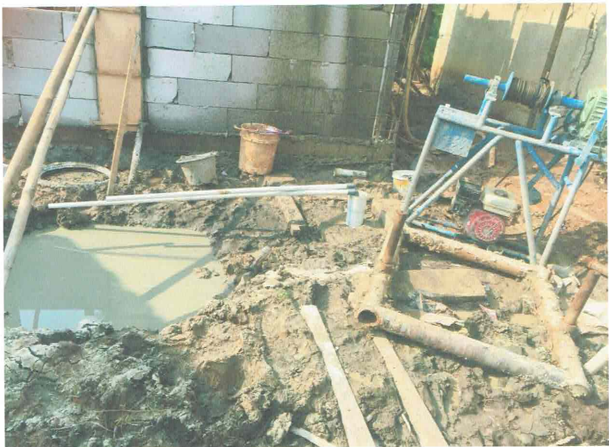
FOTO-FOTO KEGIATAN BANTUAN PEMBANGUNAN DAN RENOVASI SARANA PRASARANA IBADAH DAN PRASARANA AIR BERSIH DAN MCK, BOGOR 25 APRIL 2019
